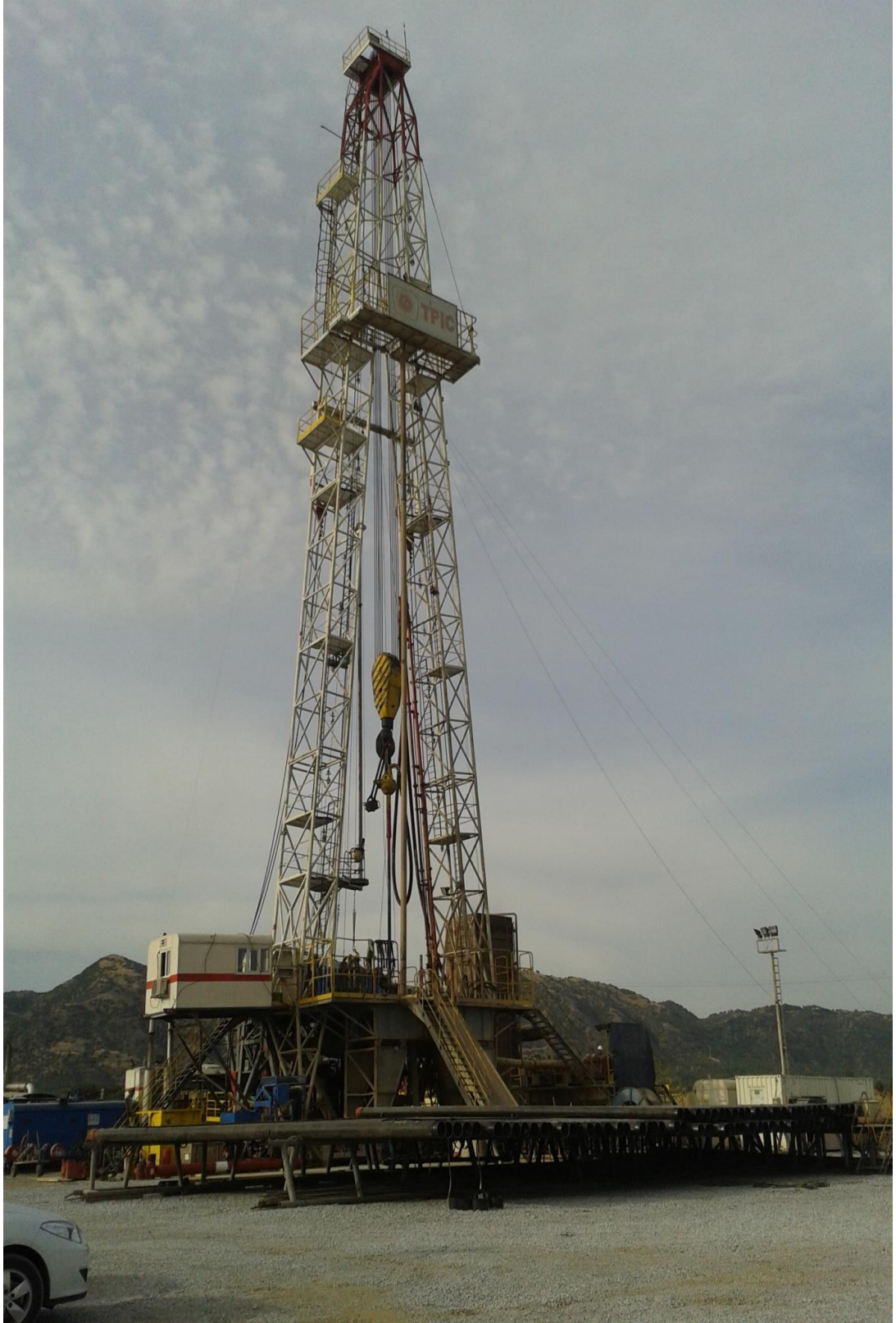
Foto 4.1. Sondaj kulesinden bir görünüm
