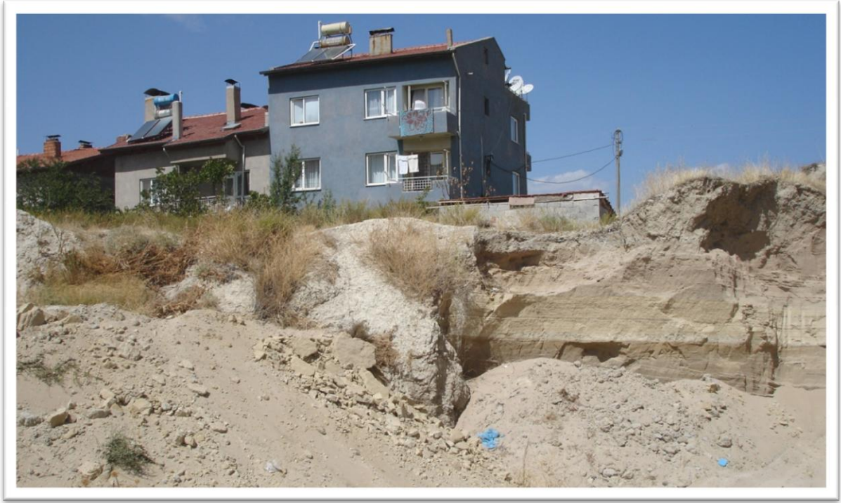
Şekil 53. Burdur’da düzgün bir alanda kurulmamış bir yapılaşmaya örnek. Burdur’da yapıların büyük bir çoğunluğu doğrudan doğruya pekleşmemiş Kuvaterner yaşlı eski gölsel plaj tortulları üzerine kurulmuştur ve zemin sıvılaşmasına maruz kalma tehlikesi ile karşı karşıyadır (GB’dan KD’ya bakış).
